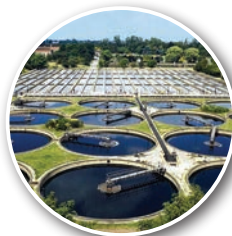
Водоснабжение и очистные сооружения
