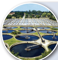
Водоснабжение и очистные сооружения
